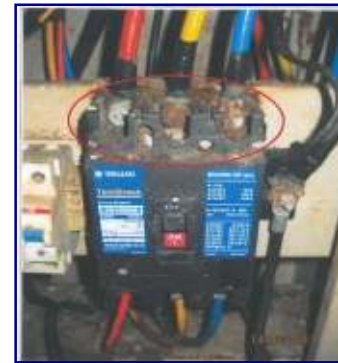
Kotoran & karat pada terminal penyambungan komponen elektrik
