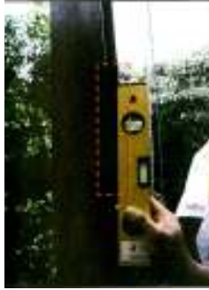
Kedudukan tiang pada jambatan gantung yang sedikit condong. Tiang pada jambatan gantung condong adalah berkemungkinan disebabkan oleh agihan beban yang tidak sekata pada jambatan
