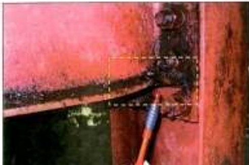
I-section tiang membengkok. Kemungkinan berlakunya 'torsional rotation' pada piling
