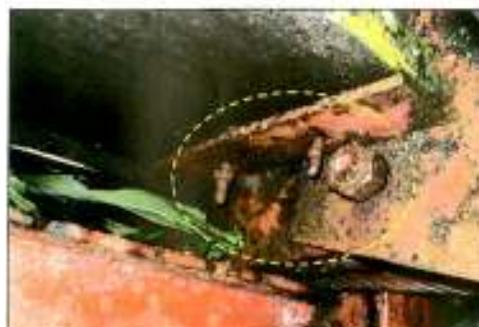
Nat skru tercabut dan hampir keseluruhan skru yang dipasang tidak menggunakan 'washer'
