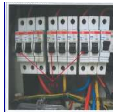
'MCB' litar akhir yang terpelantik disebabkan kerosakan yang berlaku pada litar
