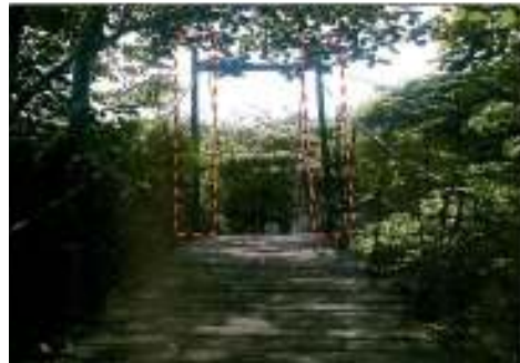
Kedudukan tiang pada jambatan gantung yang sedikit condong. Tiang pada jambatan gantung condong adalah berkemungkinan disebabkan oleh agihan beban yang tidak sekata pada jambatan
