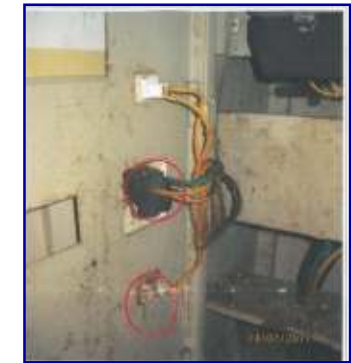
Terminal penyambungan komponen elektrik dipenuhi kotoran dan berkarat
