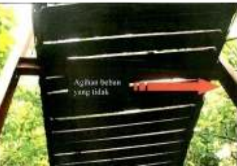
Kedudukan tiang pada jambatan gantung yang sedikit condong. Tiang pada jambatan gantung condong adalah berkemungkinan disebabkan oleh agihan beban yang tidak sekata pada jambatan
